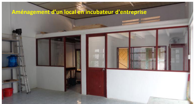
Aménagement d'un local en incubateur d'entreprise
