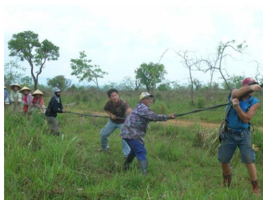
Extension d'un réseau Basse Tension au LAOS
