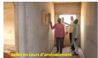
Salles en cours d'aménagement
