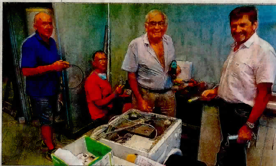
Les bénévoles d'Énergies sans frontières ont adapté le réseau électrique des locaux tignolans des Restos du cœur en vue de l'installation d'une cuisine équipée.
