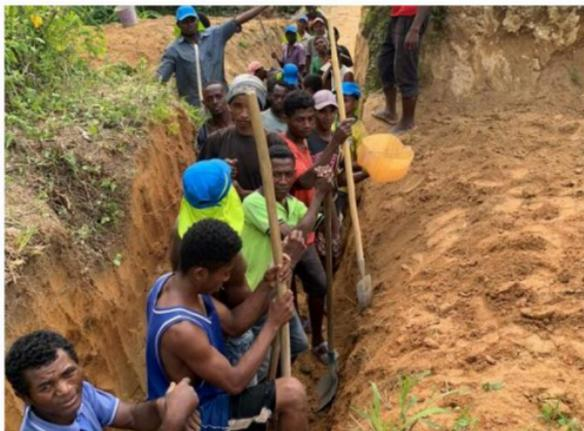
Sur place, les villageois ont creusé la tranchée permettant l'installation de la conduite forcée. Photo Énergies sans frontières
