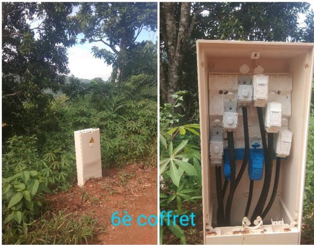
Mise en place des coffrets de jonction permettant de rabouter les câbles enterrés entre la microcentrale et le village
