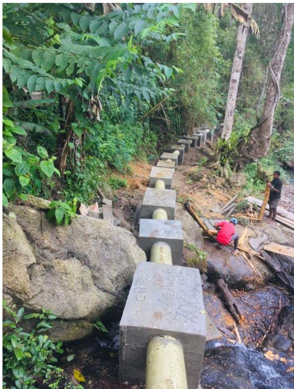
Construction des massifs de conduite forcée par les villageois
