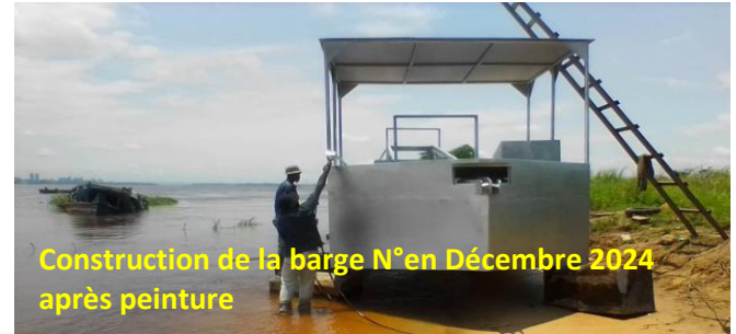
Construction de la barge N°2 en acier mécano-Soudé
