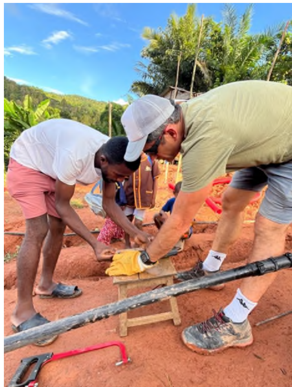
Repérage des défauts du câble 990 V et réparation
