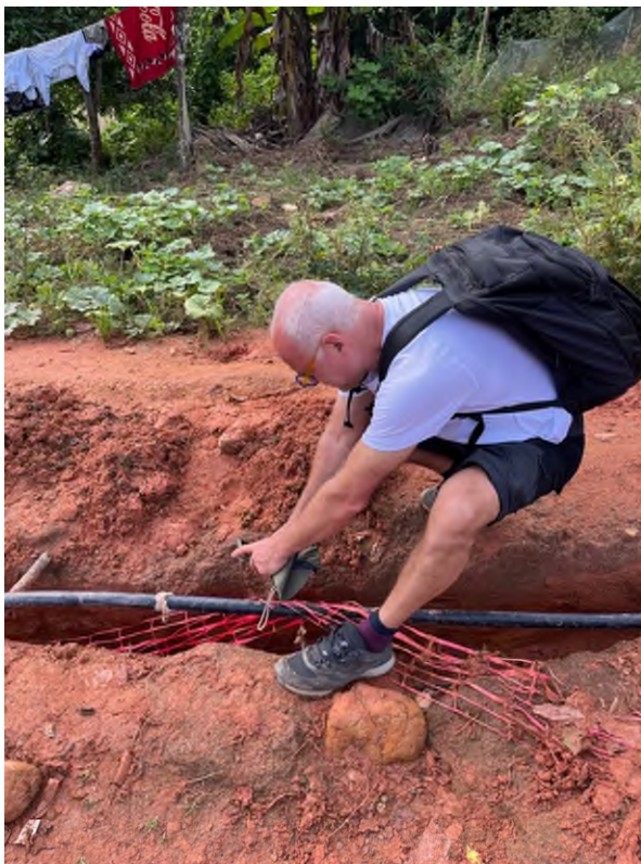
Repérage des défauts du câble 990 V et réparation
