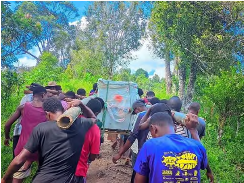
Le montage de la turbine, et le transport des équipements
